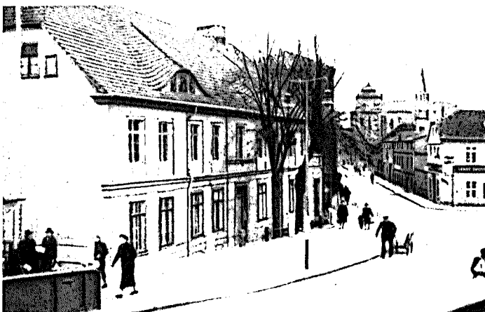
15a. Wohnhaus Stotze, Mühlent- straße 1 Aufnahme Juni 1940
