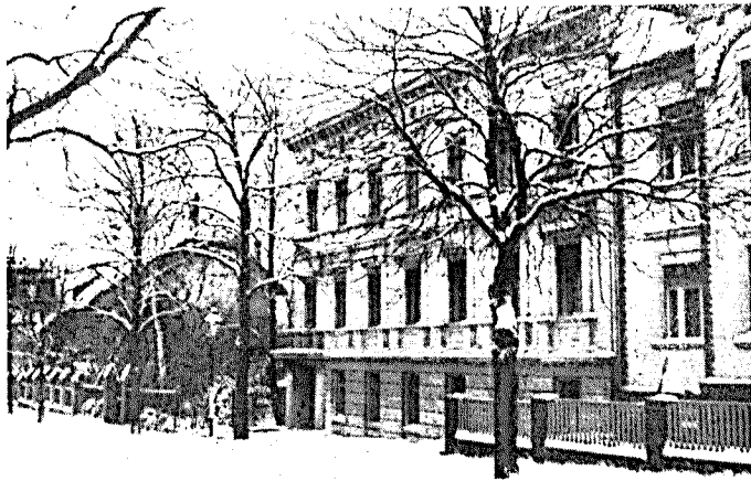
42. Haus Eberswalde, Moltkestraße 19. Erbaut 1894/95 von Wilhelm Lüdetz
